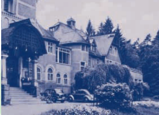
Eingangstreppe Haus Feldberg und rechts Haus Saalburg
